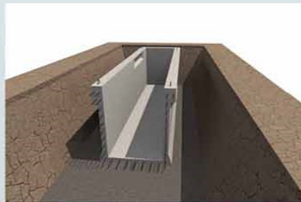
Plaatsen eerste element Pose premier élément
