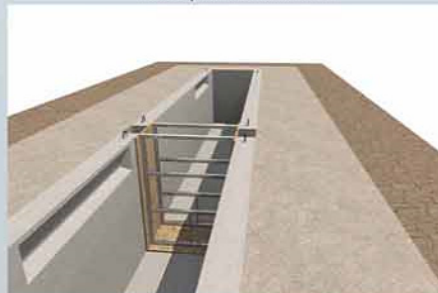
Aanvullen met gestabiliseerd zand Remblais au sable stabilisé
